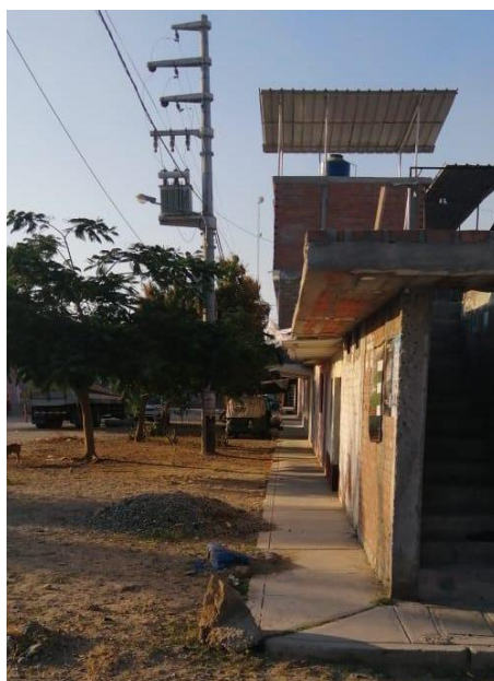
Foto N° 02: Vista del muro A-E se aprecian volados.
